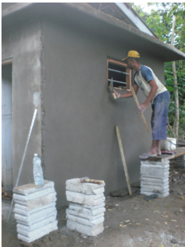
Eigenes Badezimmer für Praktikanten wird derzeit gebaut!
